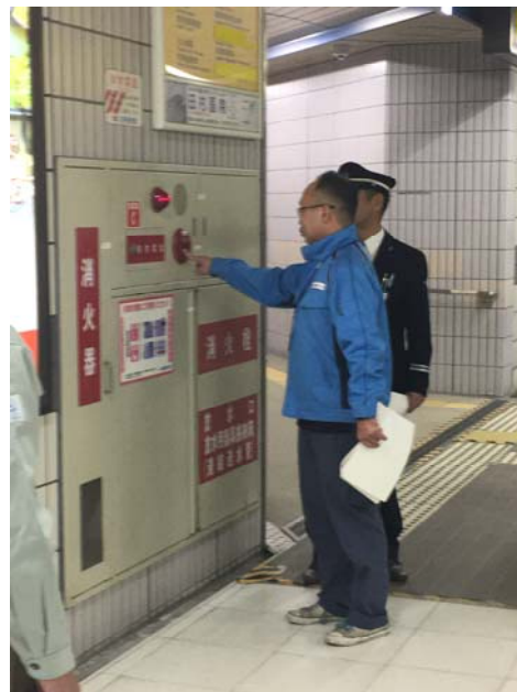
連絡通報訓練 (駅助役による火災報知器の説明)
